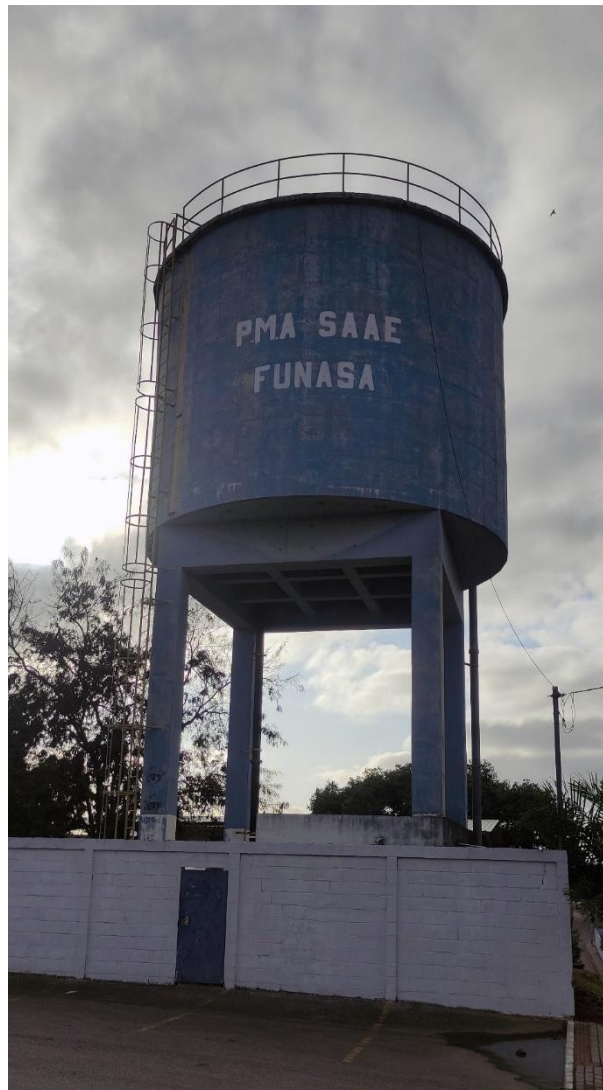
Figura 36: Reservatório São Marcos.
