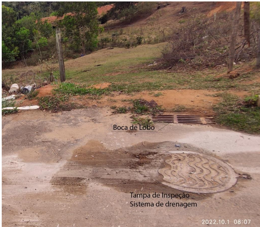
Figura 38: Identificação de boca de lobo e sistema de drenagem pluvial da Rua Darcy Ribeiro esquina Rua Celso Furtado.
