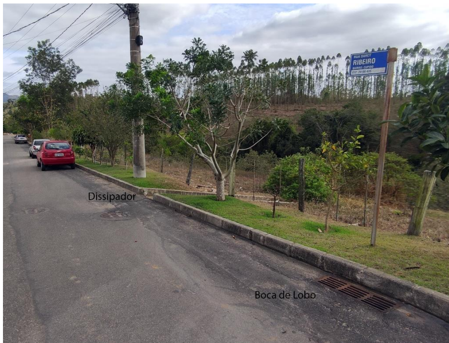
Figura 43: Identificação de sistema de drenagem pluvial e dissipador da Rua Darcy Ribeiro com Rua Dias Gomes. Fonte: Gestão Sustentável, 2022.
