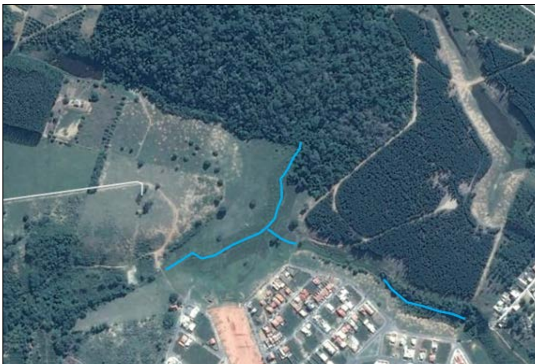
Figura 44 – Imagem aérea com a indicação dos cursos de água existentes na área do empreendimento, delimitado pelas linhas na cor azul
