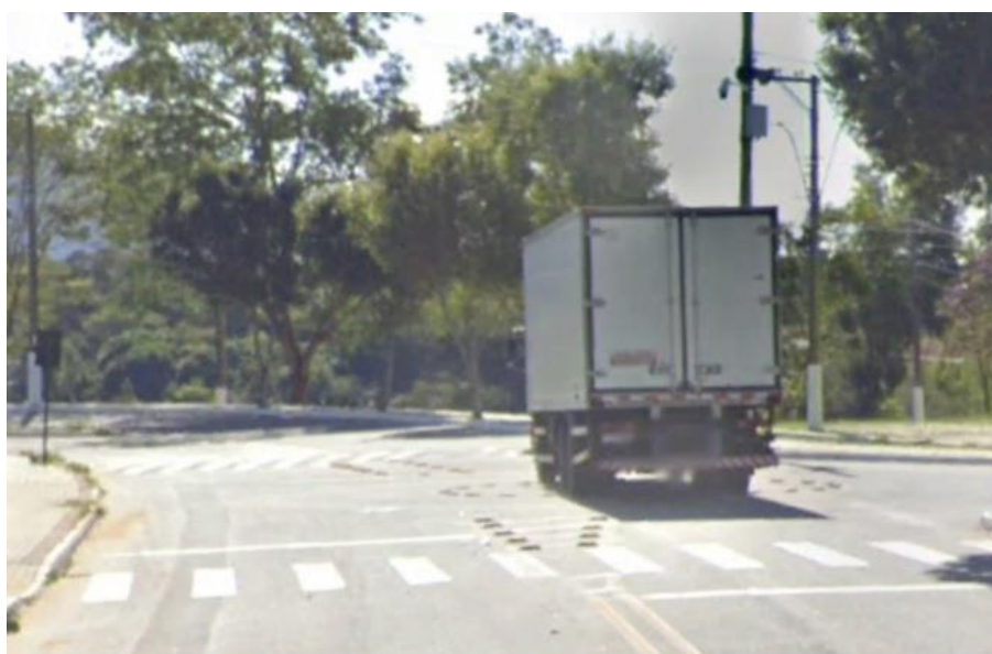
Figura 15: Tráfego de veículos de grande porte sobre mini rotatória. Fonte: GOOGLE Earth Jul/2022.
