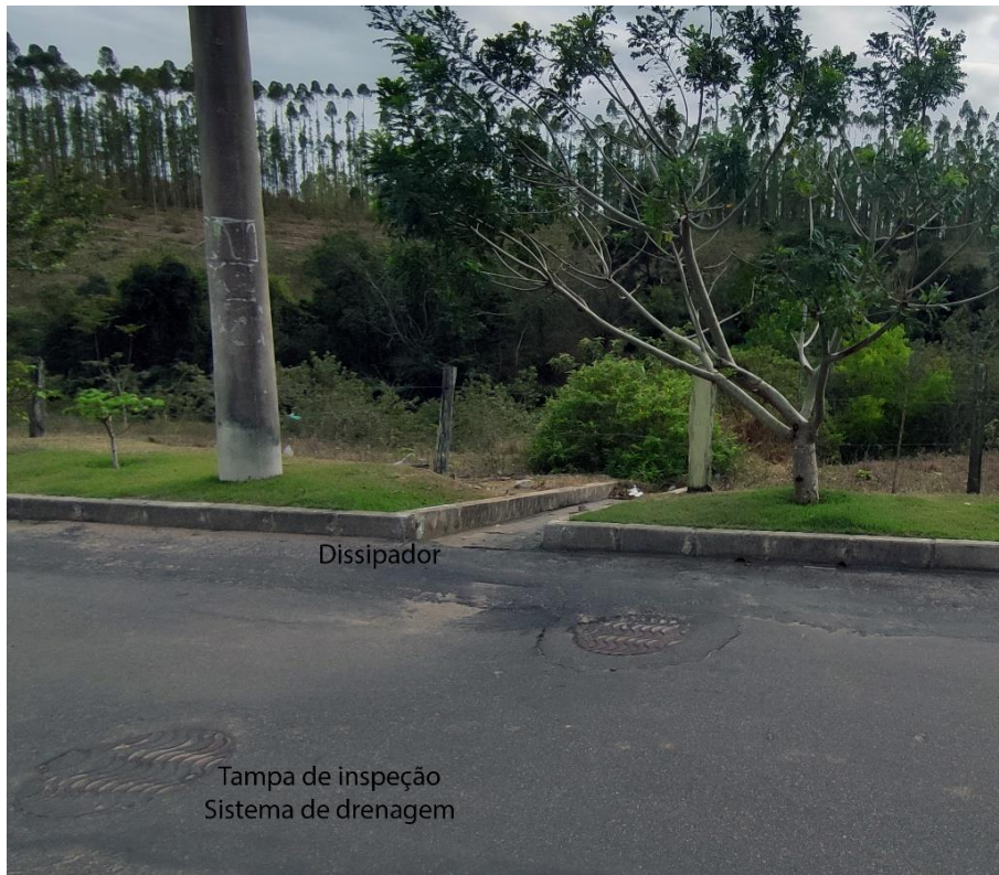
Figura 42: Identificação de sistema de drenagem pluvial e dissipador da Rua Darcy Ribeiro com Rua Dias Gomes. Fonte: Gestão Sustentável, 2022.
