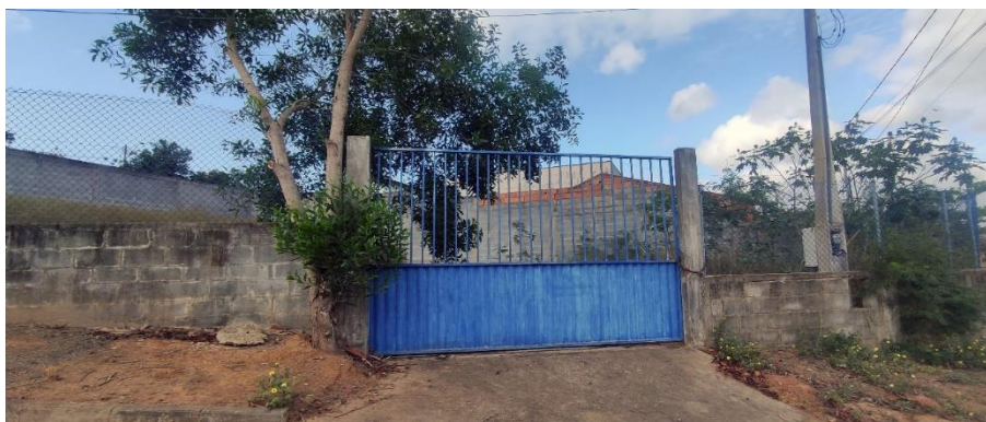
Figura 46: Local de implantação da EEE- Estação Elevatória de Esgoto. Fonte: Gestão Sustentável.
