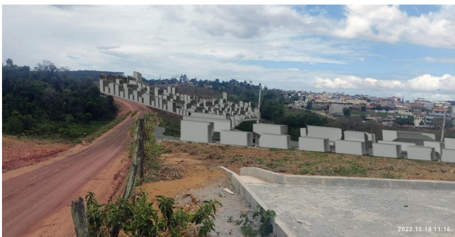
Figura 76: Cena 01 (PO 1) - Após implantação. Vista DA Estrada do contorno sentido área rural.
