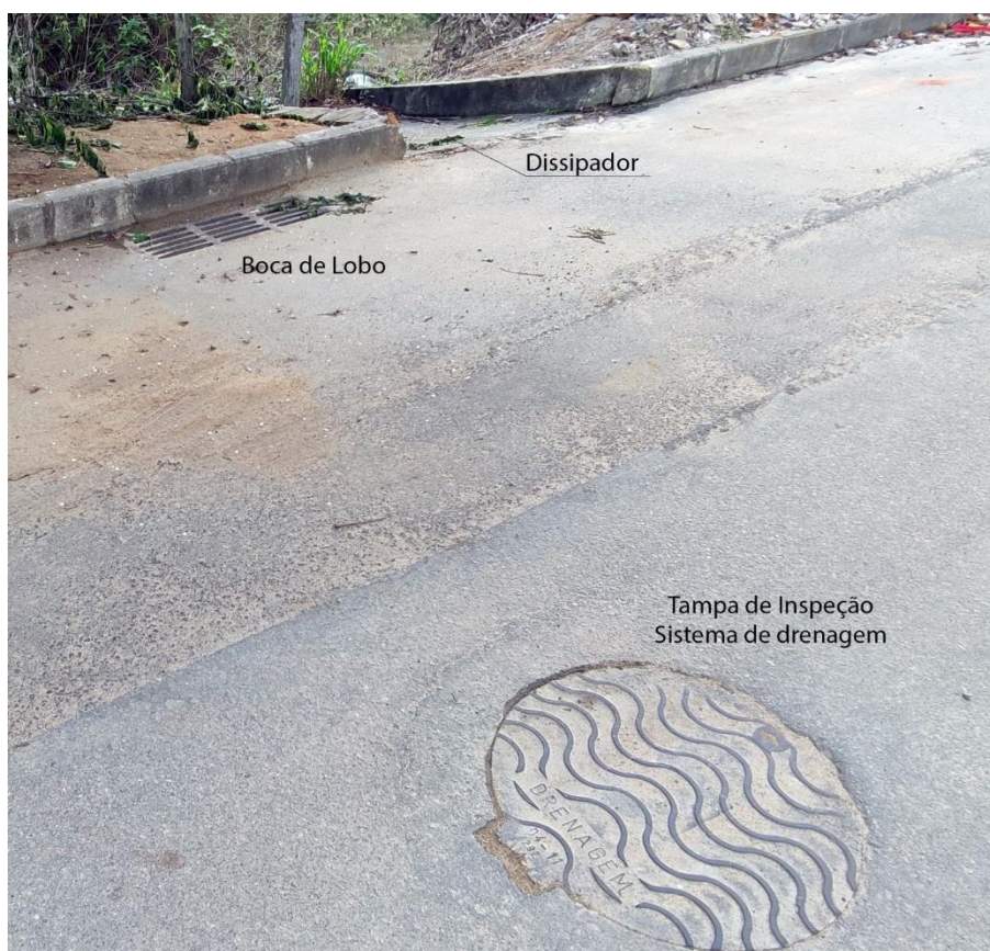
Figura 40: Identificação de boca de lobo, sistema de drenagem pluvial e dissipador da Rua Darcy Ribeiro com Rua Roberto Campos.
