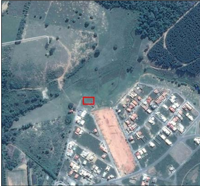
Figura 8 – Imagem demonstrando a localização do canteiro de obras, indicado pelo retângulo de cor amarela
