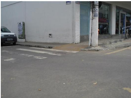
**Figura 31 – Rampa de acesso à calçada e sinalização horizontal em mau estado de conservação**
