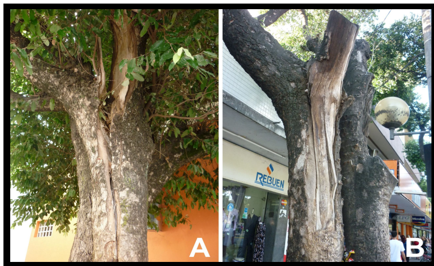
Figura 20: Rachadura na inserção do tronco e ataque de cupim, (Árvore de Risco), A - Rua Marechal Deodoro, B - Rua Marechal Floriano.
