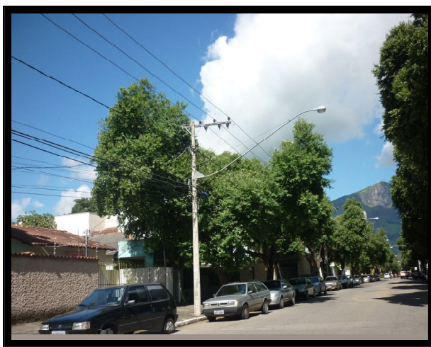
Figura 21: Redes de média Tensão Convencional ou Nua, Rua Belo Horizonte, Gov. Valadares - Minas Gerais.
